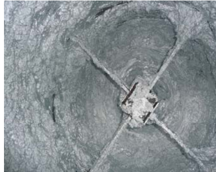
Residuo de escoria de la CGL sin aditivo para el proceso
