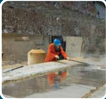
Extracción de la escoria de superficie
